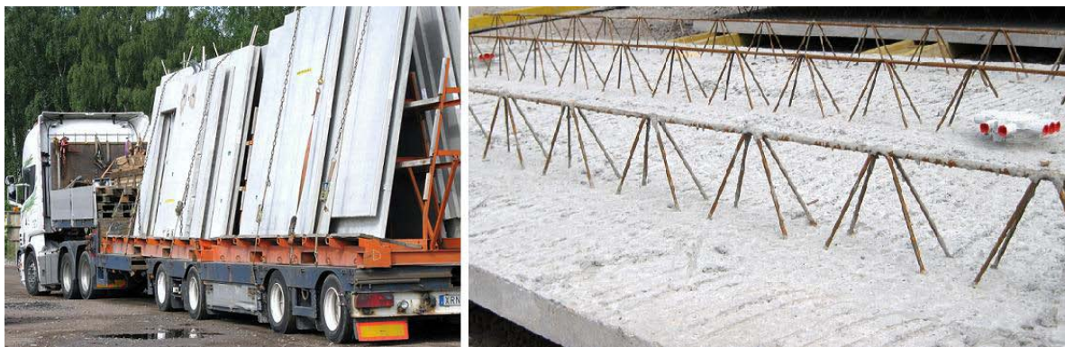
Figur 4. Till vänster: Transport med skalväggar. Till höger: Plattbärlag. Lägg märke till att betongelementet är delvis färdigarmerat samt att eldragning för exempelvis taklampor redan är förberedd.
